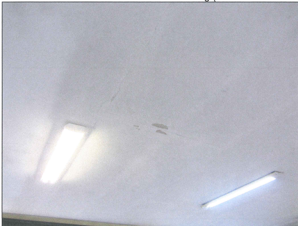
Uszkodzenie sufitu na skutek ugięcia
