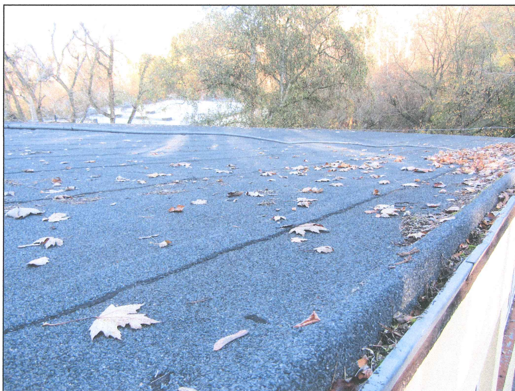
Odkształcenia dachu
