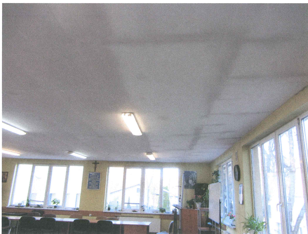
Kilkucentymetrowe ugięcie sufitu podwieszanego
